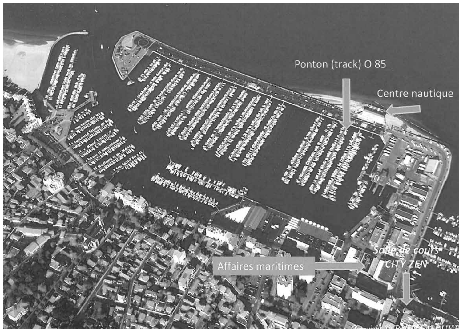
La salle de cours City'Zen se trouve au 4 Quai du capitaine Allégre - Arcachon.
